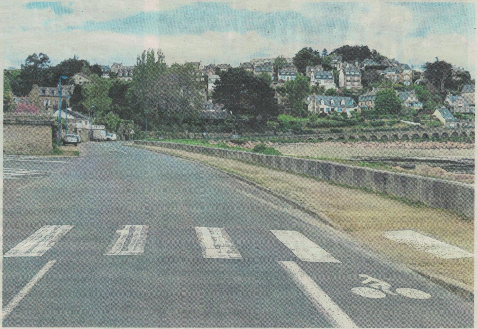
Boulevard de la Mer, la bande cyclable doit être prolongée jusqu'à la rue de Trestrignel.
