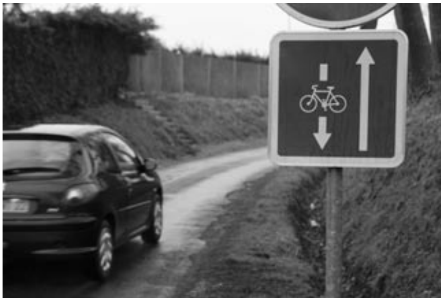
Sur le chemin de l'ASPTT, un contresens cyclable a été installé. Un exemple d'aménagement efficace et à moindre coût.
